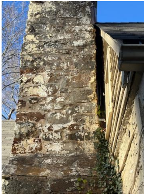
STONE CHIMNEY - LEFT
