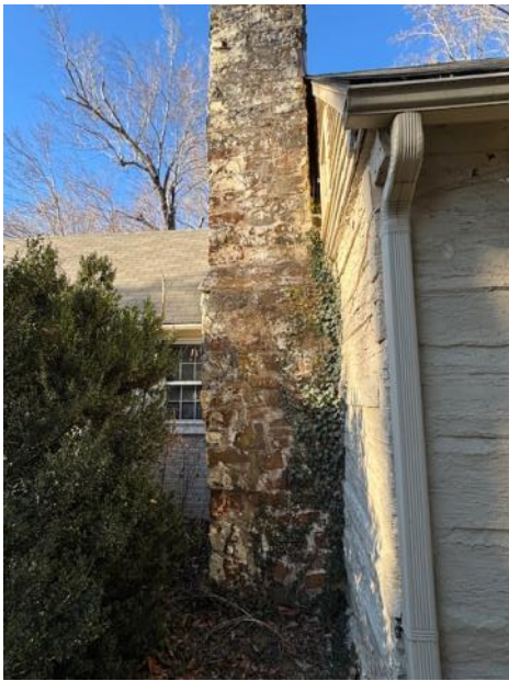
STONE CHIMNEY - LEFT
